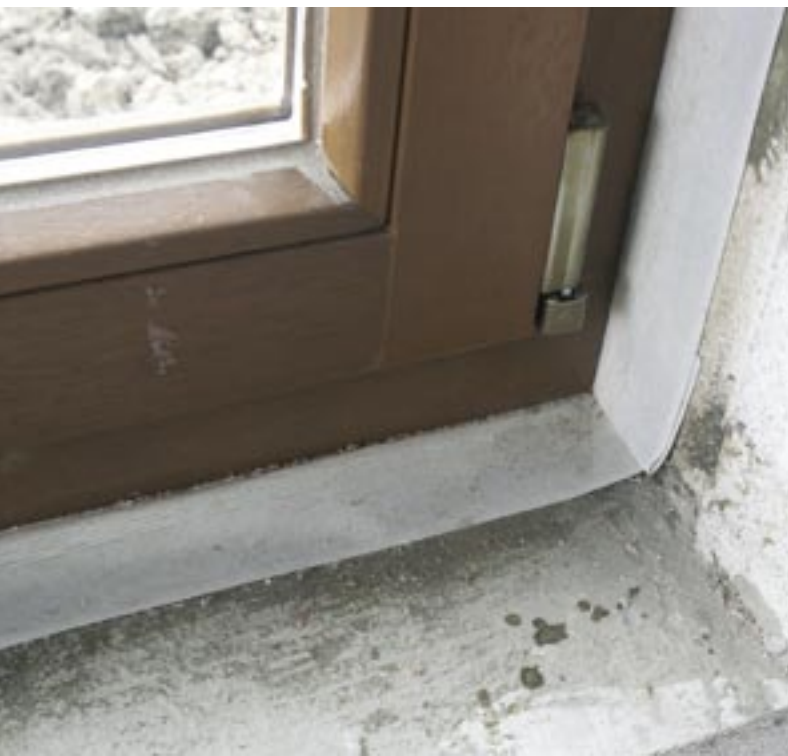
Abb. 5 Eckausbildung mit Fensteranschlussfolie, innen
