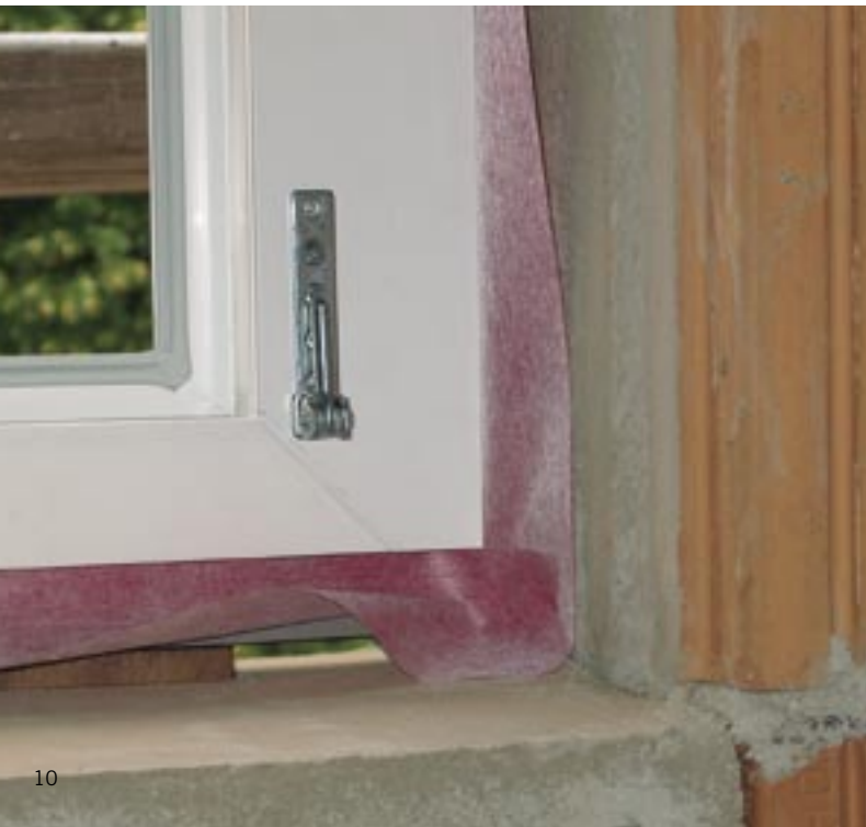
Abb. 8 Eckausbildung mit Fensteranschlussfolie und Klebepaste auf Glattstrich
