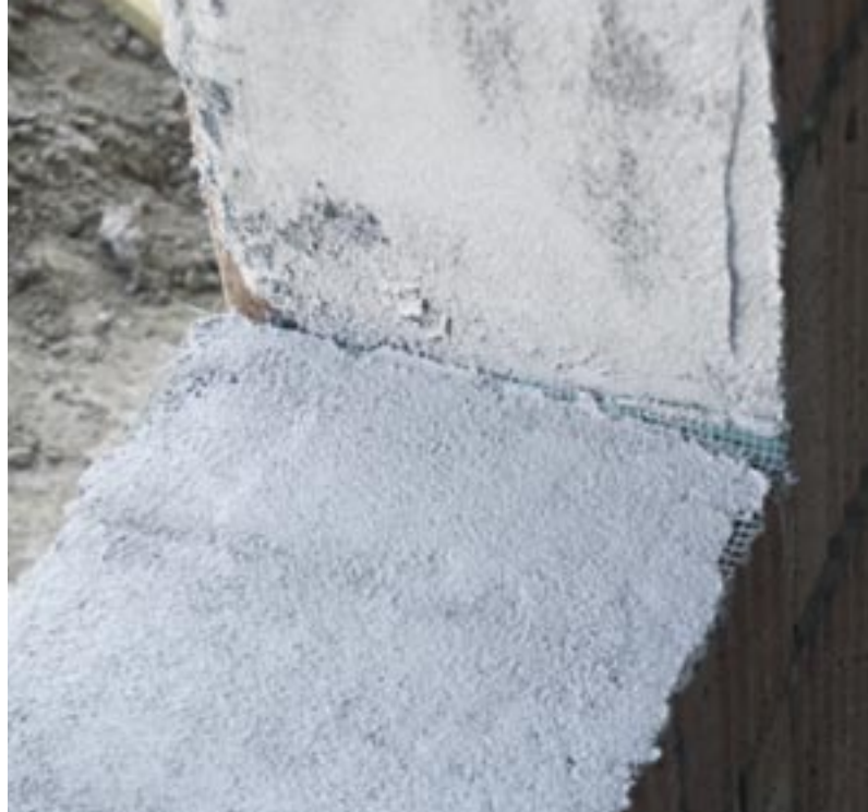
Abb. 2 Rohbausituation mit Glattstrich
